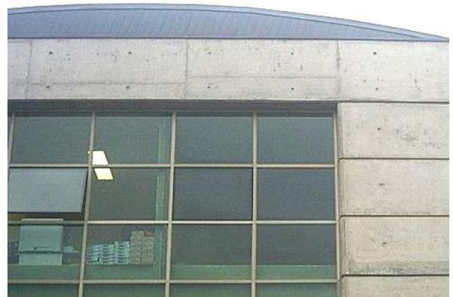
Figura 13.- Edificio Liceo Camilo Henríquez, Temuco (intención de Hormigón Arquitectónico no lograda).
