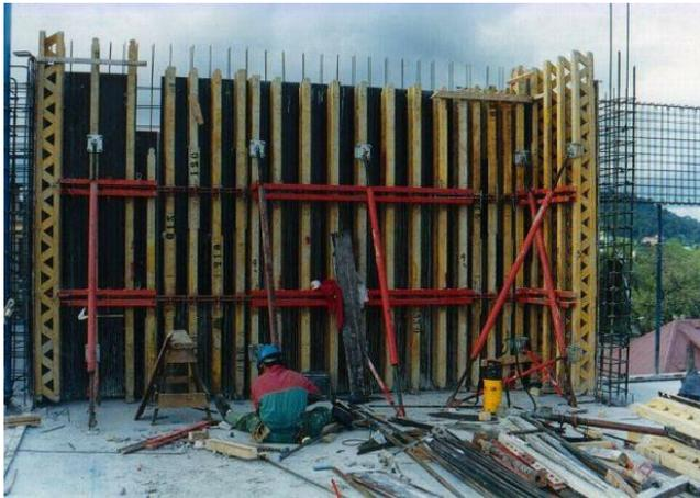
Figura 7.- Moldaje Peri Vario con vigas GT 24 (Edificio Fac. de Medicina Universidad de La Frontera). [4]
