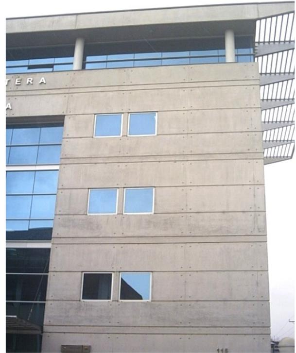
Figura 6.- Expresión final en el muro terminado exactamente igual a lo indicado en el plano constructivo. [4]
