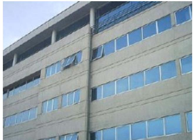
Figura 3.- Edificio Facultad de Medicina de la Universidad de La Frontera, traslape de muros para ocultar juntas de dilatación y bajadas de aguas lluvias. (Autor)
