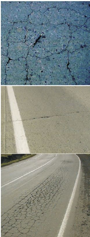
Figura 10: Fisuración de bloque, transversal y de fatiga. Fuente: [32]
