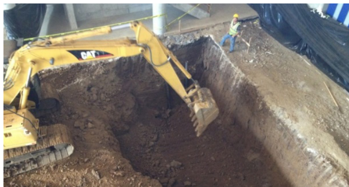
Figura 1 Excavación de la fosa para la construcción de las pistas
