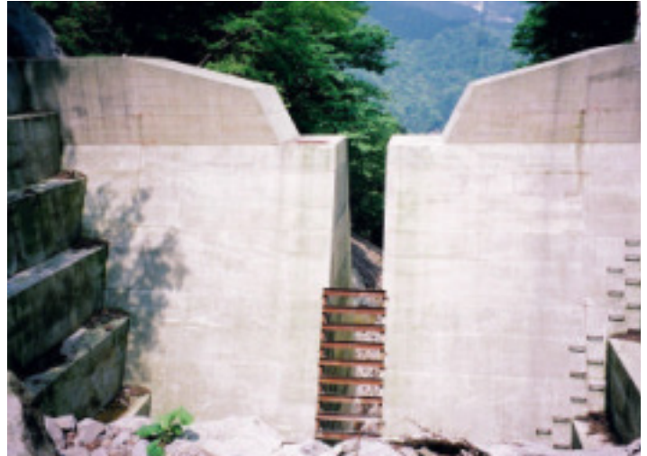
Figura 10. Presa SABO de concreto con hendidura. Las barras de acero se han instalado en la ranura, la rendija actúa como drenaje quitándole el agua al flujo y el muro detiene las rocas. (Fuente: Mizuyama, T.; 2008).
