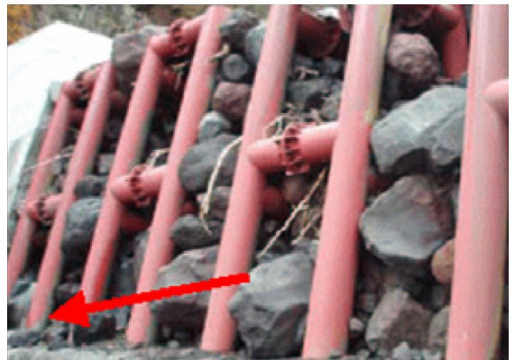
Figura 8. Presa SABO de tubos de acero (tipo abierto) ha atrapado grandes rocas del flujo escombros en la isla de Rishiri-Japón en 2007. (Fuente: Mizuyama, T.; 2008)
