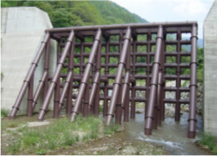
Figura 9. Presa SABO de tubos de acero, se usa como estructura extremo aguas abajo del torrente de arrastre. Su apertura es pequeña, casi igual al diámetro de las rocas transportadas en la parte delantera de flujo de escombros. (Fuente: Mizuyama, T.; 2008).
