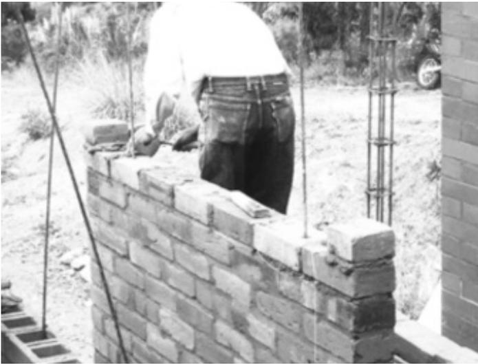
Figura 18: Muro de ladrillo “panelón “ artesanal para presforzarse en proceso de construcción.
