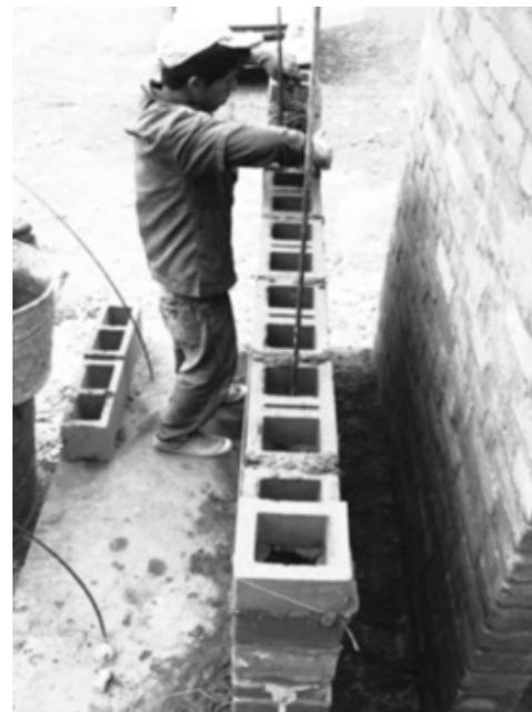
Figura 20: Muro de ladrillo industrial para presforzarse en construcción.
