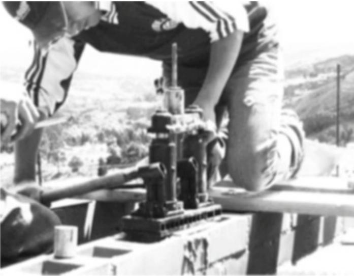
Figura 5: Resultado de adaptar la gata automotriz para presforzar.
