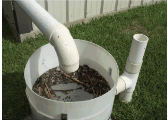
Figura 13. Tanque de prefiltro
