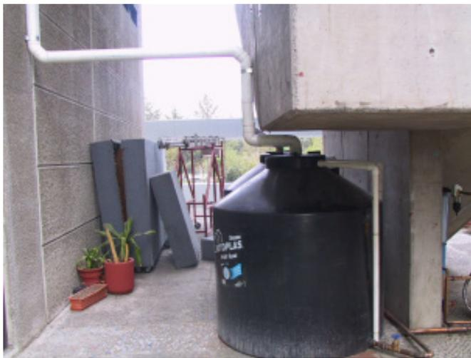
Figura 11. Cisterna prefabricada de plástico
