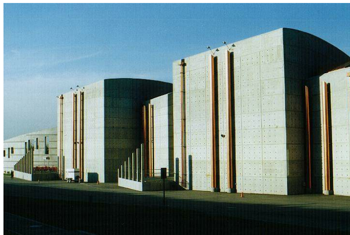
Fig. 6 Edificio Museo Interactivo El Mirador, Santiago, (Hormigón Arquitectónico).
