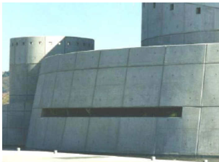
Fig. 5 Edificio Spa Balthus, Santiago (Hormigón Arquitectónico). Obsérvese la lisura del muro curvo y las líneas de canterías que dan ritmo y unidad a la fachada del edificio.
