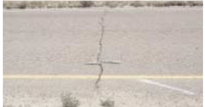
Figura 14. Fisuración transversal Fuente: FHWA, 2003
