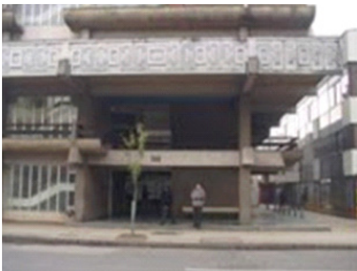
Fig. 4.- Ex. edificio de los Tribunales en Calle Prat en Temuco, (Hormigón a la vista).
