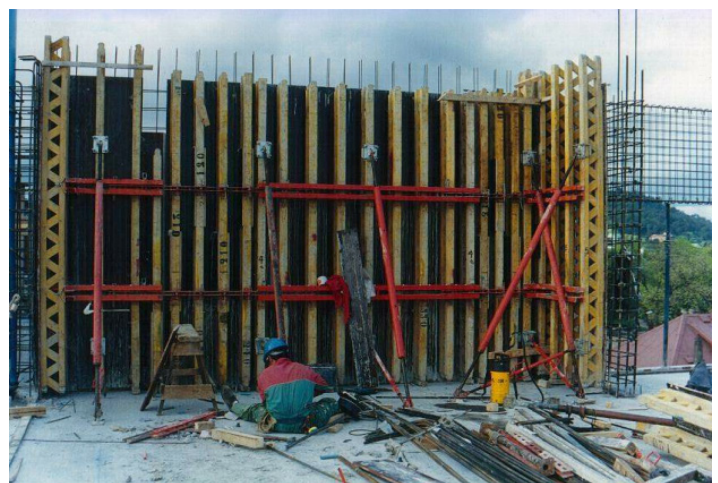
Fig. 9 Moldaje Peri Vario con vigas GT 24 (Fac. Medicina UFRO)
