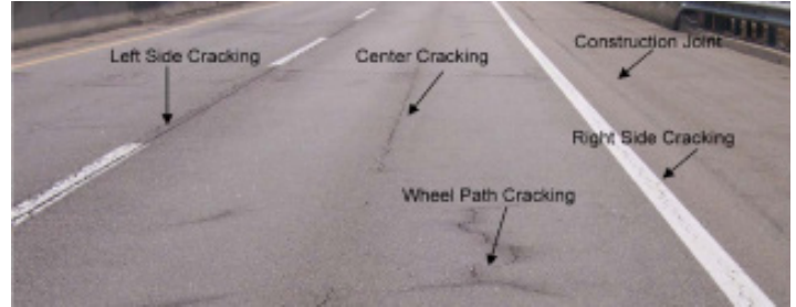
Figura 4. Tipos de fisuración en pavimentos asfálticos (Fuente: Kuai et al., 2009)
