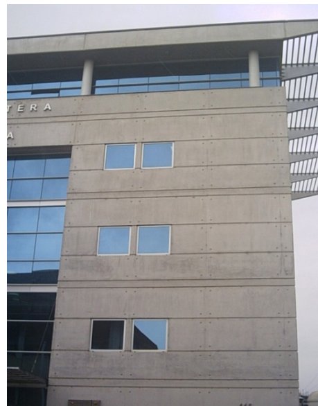
Fig. 11 Expresión final en el muro terminado exactamente igual a lo indicado en el plano constructivo
