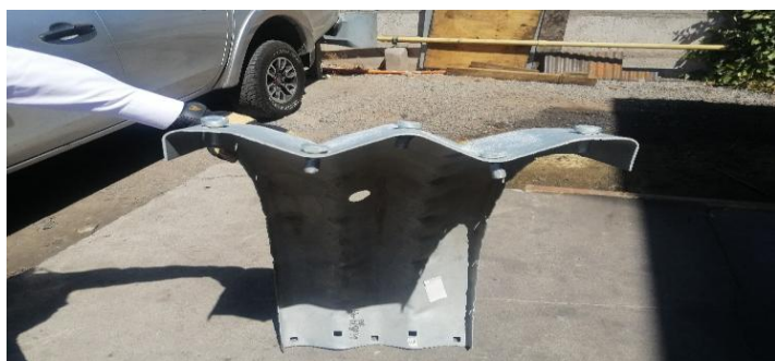
Figura 5. Todos los pernos de cuello cuadrado están colocados en la cola de la plancha y fijados con su clip. La plancha está lista para ingresar al túnel o pique y ser colocada en su posición.
