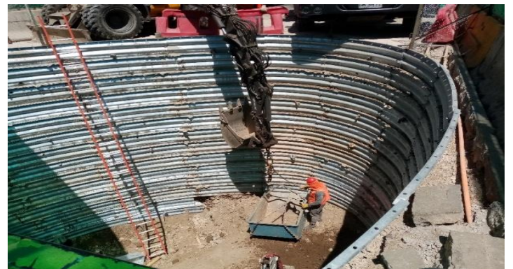
Figura 11. Montaje de planchas Tunnel liner del pique 1 de configuración elíptica.
