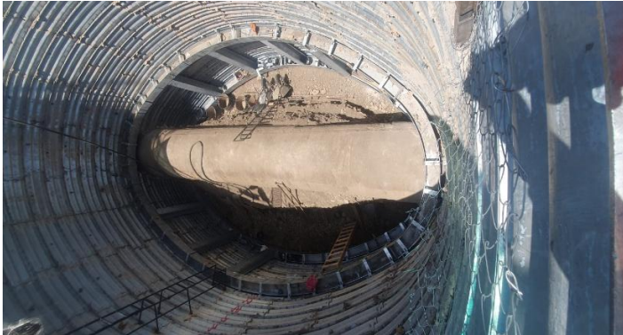
Figura 13. Vista cenital del pique elíptico con todos sus refuerzos.
