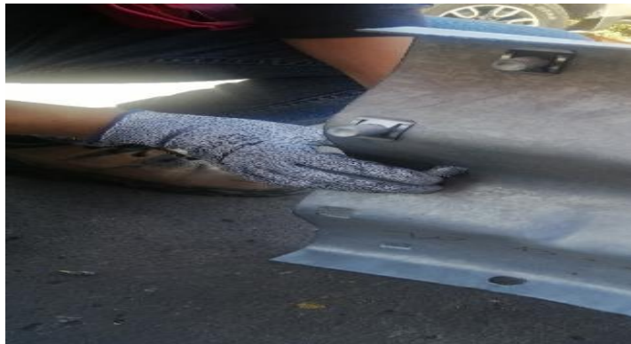
Figura 4. Colocación de pernos de cuello cuadrado en los agujeros cuadrados de la "cola" de la plancha y fijados por el clip.
