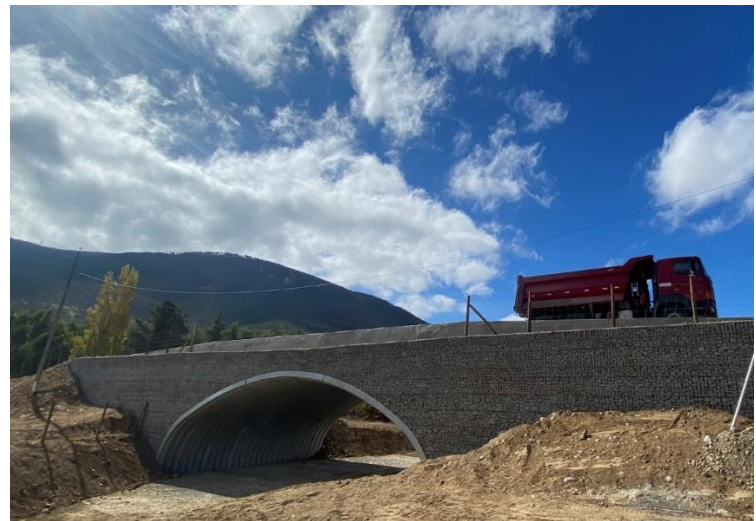
Figura 1. Puente El Name, Cauquenes.
