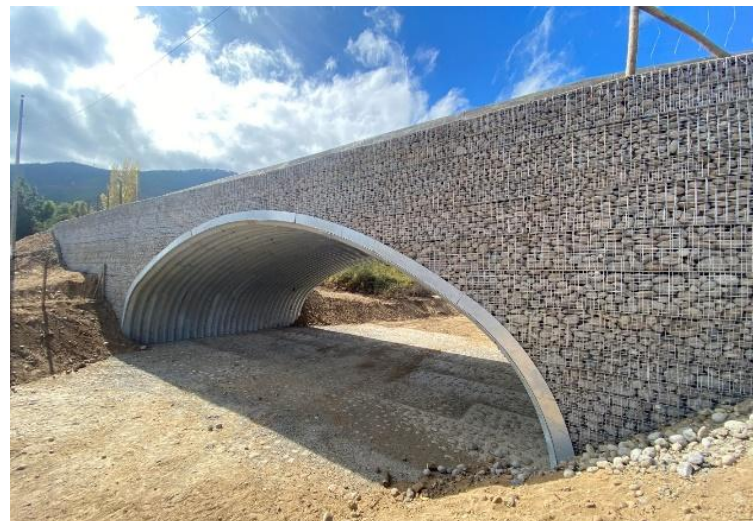
Figura 2. Puente de acero corrugado, montaje terminado.
