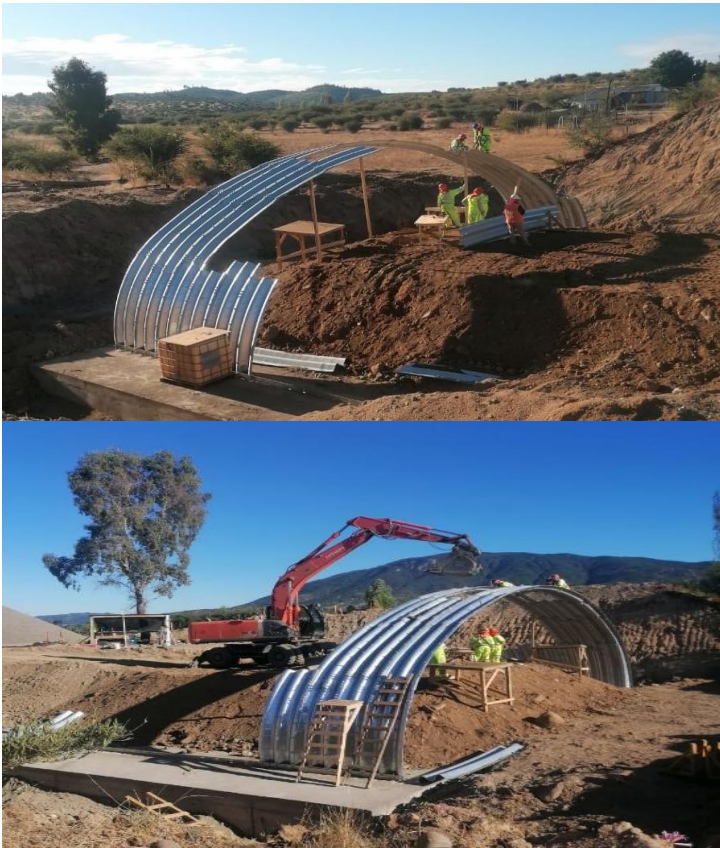
Figura 3. Ensamble por plancha.
