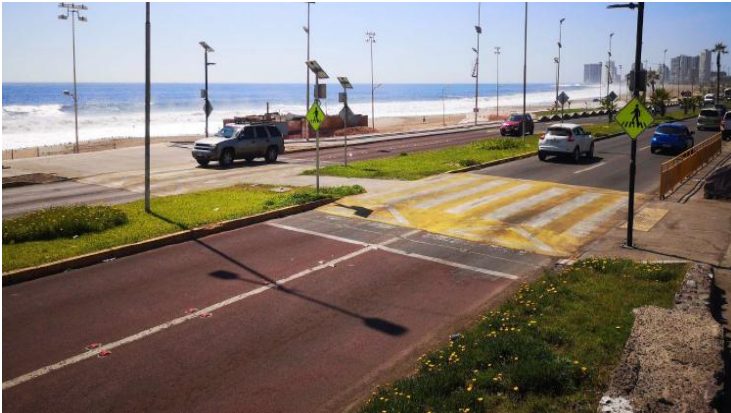
Figura 6. Acera Continua con paso peatonal inteligente, Avenida Arturo Prat, Iquique.
