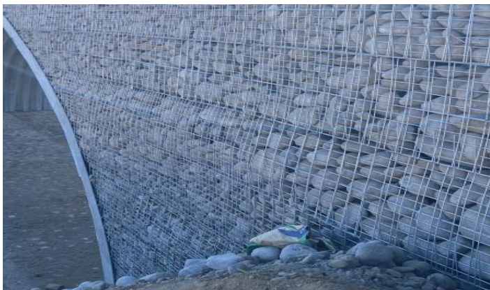
Figura 8. Terminación muro TEM con bolones.
