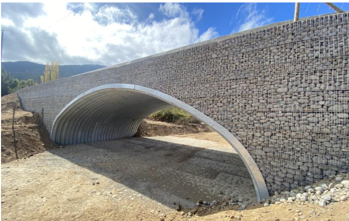
Figura 11. Puente El Membrillo con su estructura completamente finalizada.
