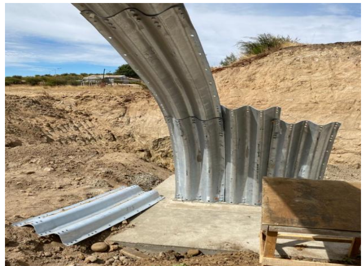
Figura 10. Montaje de planchas corrugadas Puente El Membrillo.
