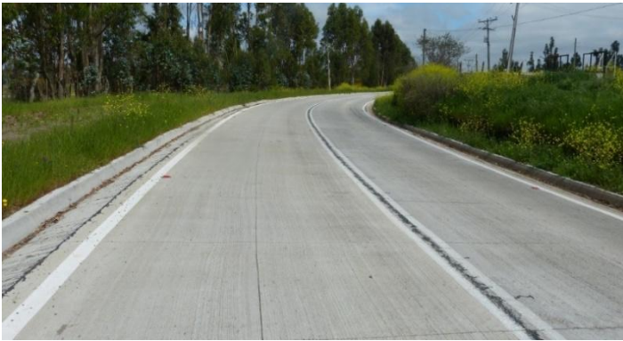
Figura 4. Ruta G-84 construido con U-TCP.
