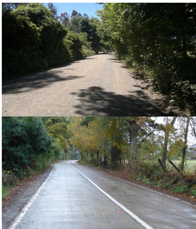
Figura 2. Estado antes/después de la pavimentación.
