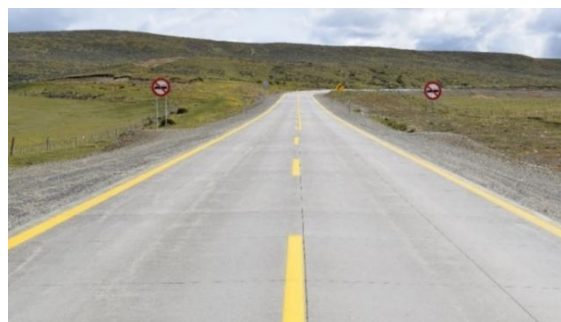
Figura 5. Ruta 257 Ch Tramo I.
