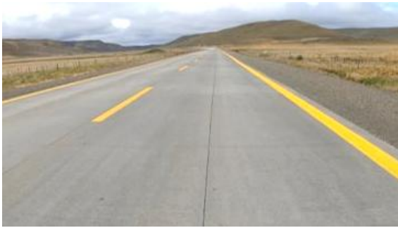
Figura 8. Ruta 257 Ch Tramo III.
