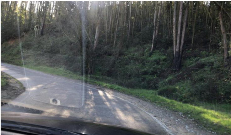
Figura 6. Calzada única con 3,00 m de ancho total; fotografía en sentido ascendente del kilometraje.
