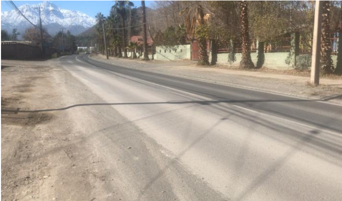
Figura 5. Recapado sobre carpeta de hormigón, vista en el sentido descendente del kilometraje.
