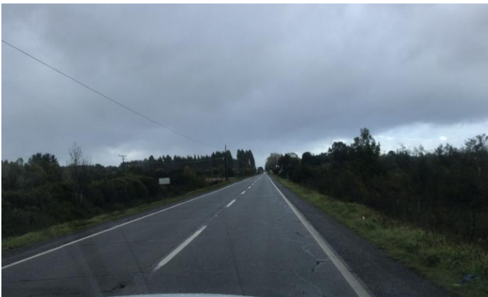
Figura 3. Caso extremo de grietas en pavimento de hormigón.
