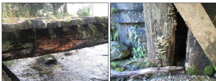
Figura 1. Daños que reducen la durabilidad de puentes de madera.
