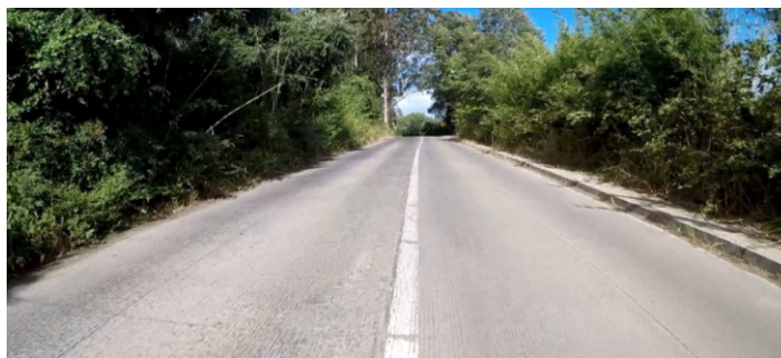
Figura 3. Estado general pavimento a 6 años de construido
