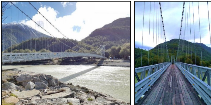
Figura 1. Fotografías del puente colgante “Pasarela Exploradores”.
