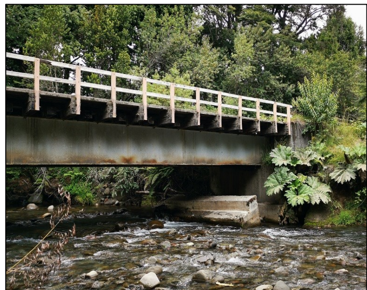
Figura 9. Tablero del Puente El pescado N° 2 ubicado en el km 5,84 de la Ruta V-613. El ancho total del tablero es de 4,8 m con un ancho de calzada de 3,6 m y dos pasillos de 0,6m. Foto del autor.
