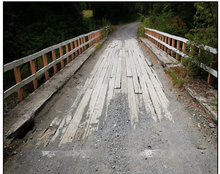
Figura 9. Tablero del Puente El pescado N° 2 ubicado en el km 5,84 de la Ruta V-613. El ancho total del tablero es de 4,8 m con un ancho de calzada de 3,6 m y dos pasillos de 0,6m. Foto del autor.
