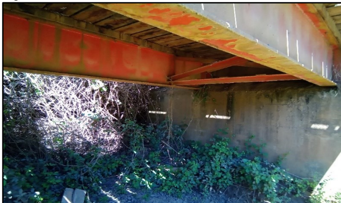
Figura 2. Vigas y estribos del puente “El Tequel”, Latitud -36.114024, Longitud. -72.319560. Foto del Autor.
