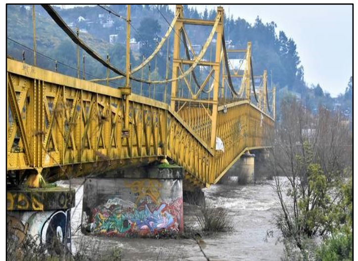
Figura 5. Imagen del puente ferroviario sobre el Río Cautín colapsado por socavación de uno de sus apoyos debido a la crecida del Río.
