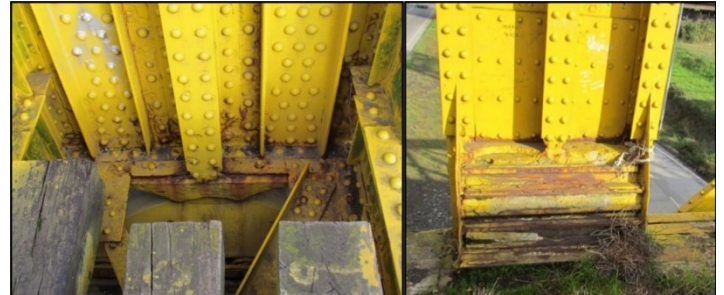
Figura 4. Izquierda, Muestra el grado de oxidación de la viga principal del puente sobre el apoyo. Derecha, muestra la reparación realizada en otro apoyo, al parecer debido a la misma situación. Foto del autor.
