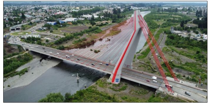
Figura 5. Mástil del puente Treng Treng Kay Kay, en vista general (© Civilab UACH).
